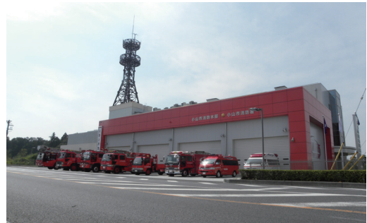
新消防本部庁舎
